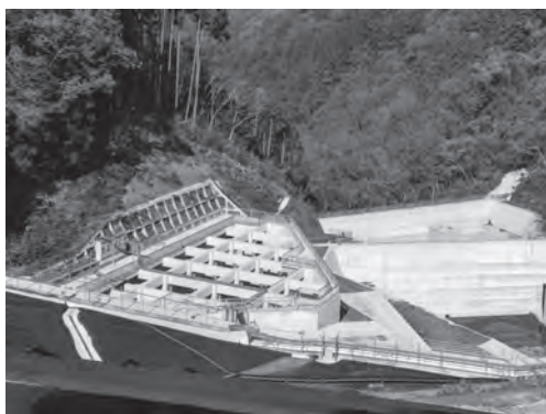
写真10 浸出液貯整池
