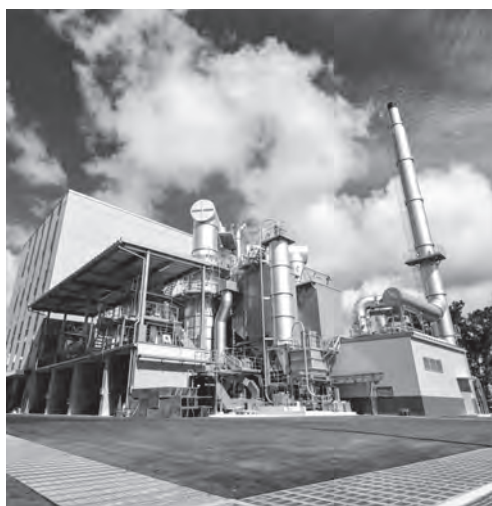
写真4 焼却施設(全景)
