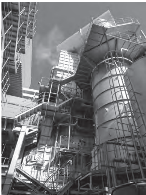
写真5 焼却炉（ロータリーキルンとストーカ炉）
