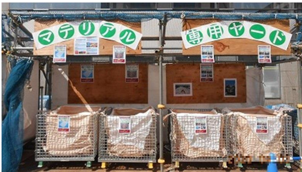
写真3 プラスチック新法への対応に向けた新しい廃プラスチック分別の試行例
