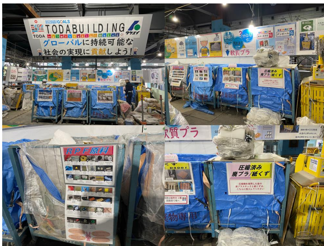
写真4 モデル現場における廃プラスチック類の分別の様子
