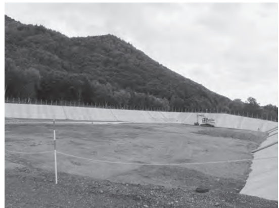
写真 4 最終処分場：鉛業所敷地内に管理型最終処分場を有する
