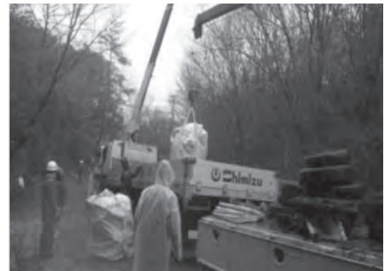
図6 廃棄物エコ手形制度を利用した撤去作業
