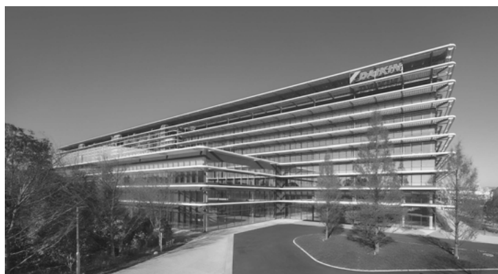
写真 ダイキン工業株式会社 テクノロジー・イノベーションセンター
