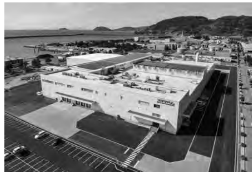
プリマハム（株）鹿児島工場全景
