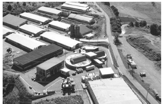
写真2 ながめやまバイオガス発電所
