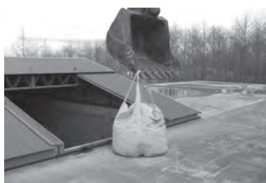
写真3 埋立槽への産業廃棄物の投入1
