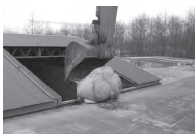
写真4 埋立槽への産業廃棄物の投入2
