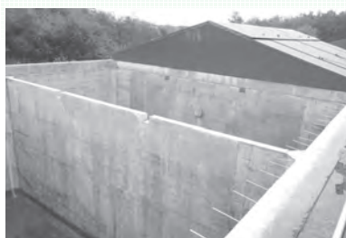
写真2 遮断型最終処分場の未使用の埋立槽
